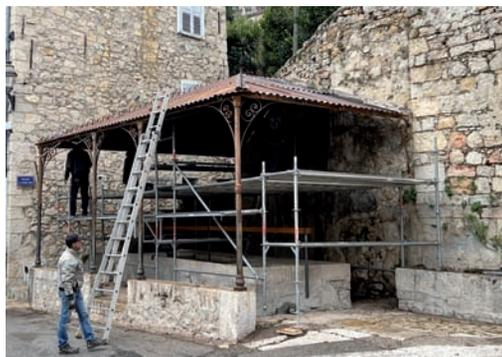
Coup de jeune pour le Lavoir avec un rafraîchissement des peintures de l'ensemble de l'ouvrage et dans un 2<sup>ème</sup> temps le remplacement des tôles et des frontons du toit.
