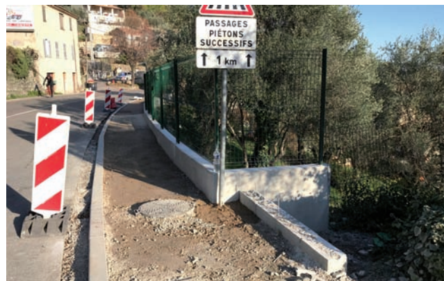
On ne circulera plus à pied sur la RD2210 grâce au nouveau trottoir
